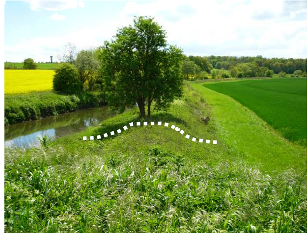
Mise en place de Merlons.
