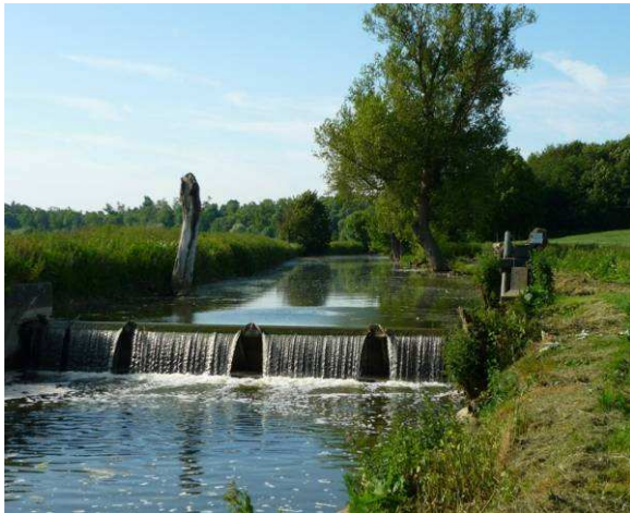
Vanne-clapet d'Evry-Gregy, le 6 juin 2009
