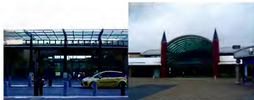
82- L'entrée de la gare RER de Val d'Europe
