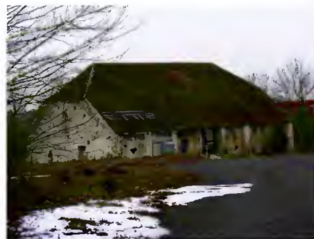
37- La grange aux dîmes du château de Coupvray
