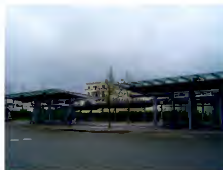
85 - Gare routière de Val d'Europe
