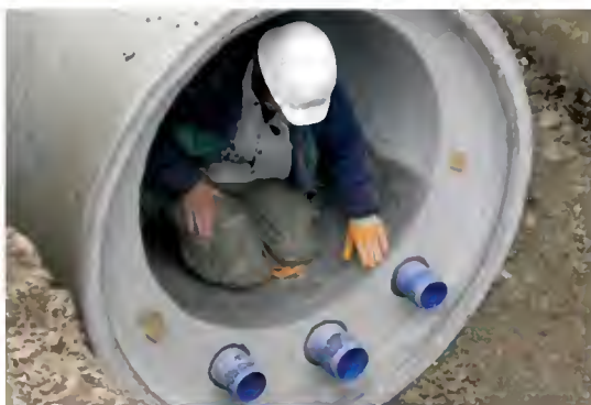
Figure 11. Canalisation préfabriquée avec échangeur de chaleur intégré (Source : Guide pour les maîtres d'ouvrages et les communes, OFEN)
