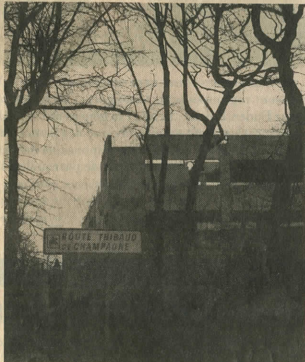
Avec ces constructions en béton armé inachevées et irrécupérables, le parc de Rentilly est défiguré. Photo FRANCE-SOIR
