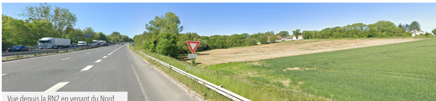
Vue depuis la RN2 en venant du Nord
