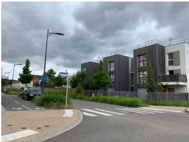
Constructions contemporaines avenue Olympe de Gougès
