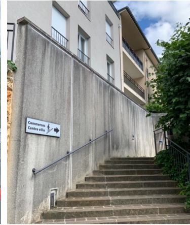
Escalier rue du Jeu d'Arc
