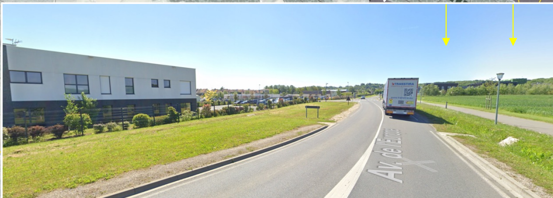
Avenue de l'Europe // Nouvelle entrée. Des aménagements généreux et de qualité. Les constructions au premier plan et en arrière plan montrent la continuité de l'espace urbain.
